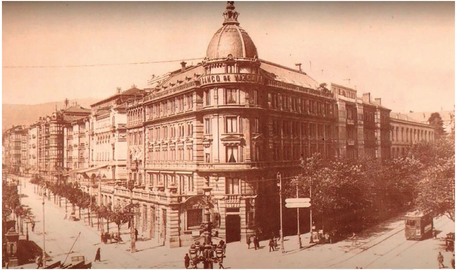
Edificio de la Central del Banco de Vizcaya, en Bilbao, en los primeros años.
